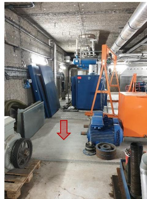
6 – Emplacement pour l'ajout d'un surpresseur d'air pour alimentation en air process du nouveau biofiltre N
