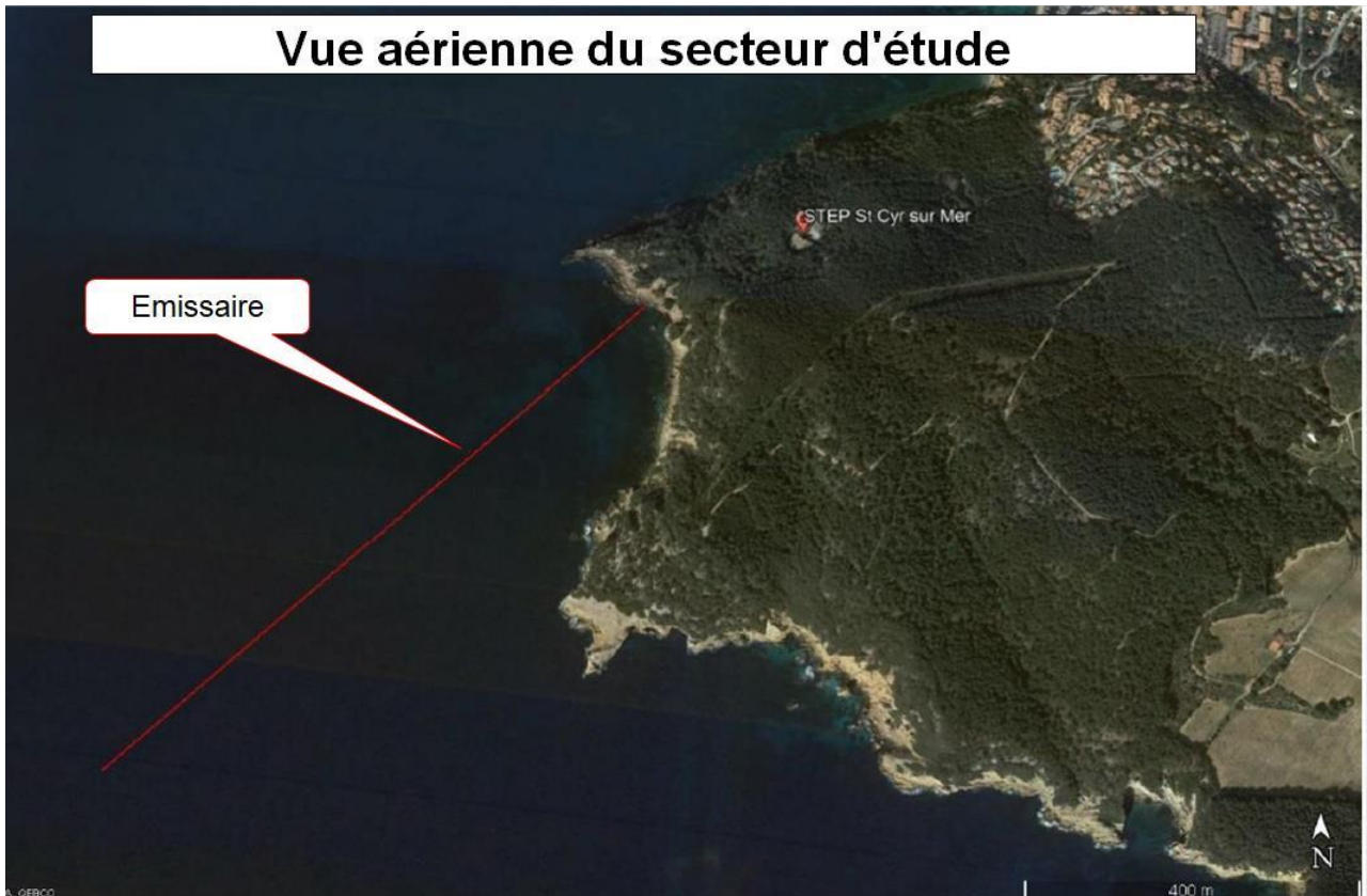
Vue aérienne du secteur d'étude
