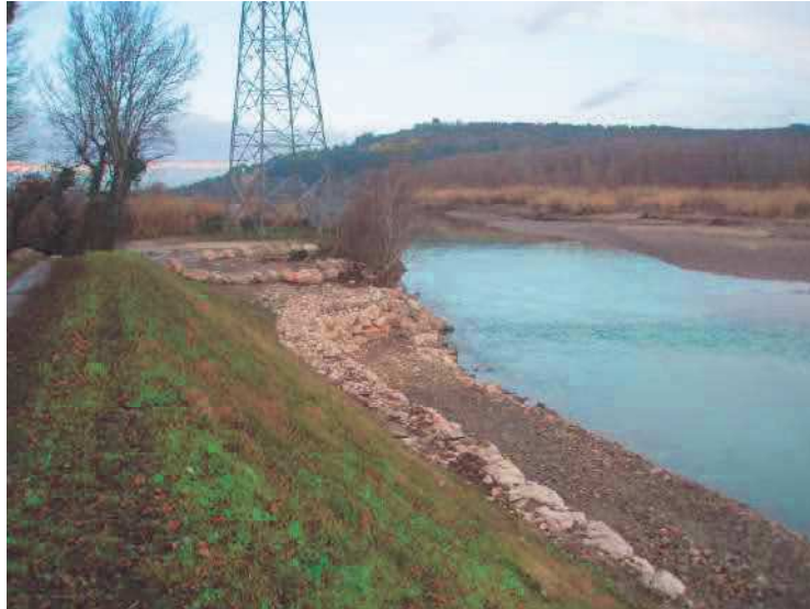
Exemple d'encrochements E-S2 existants sur le pylône 210, raccordement sur la digue existante du SMAVD non concerné par la demande
