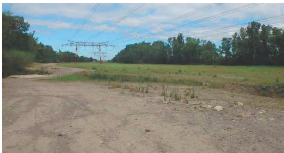
Figure 3: Illustration de travaux de désenlimonement
