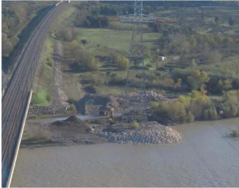
Travaux d'enrochements au droit du pylône 180, non concerné par la demande
