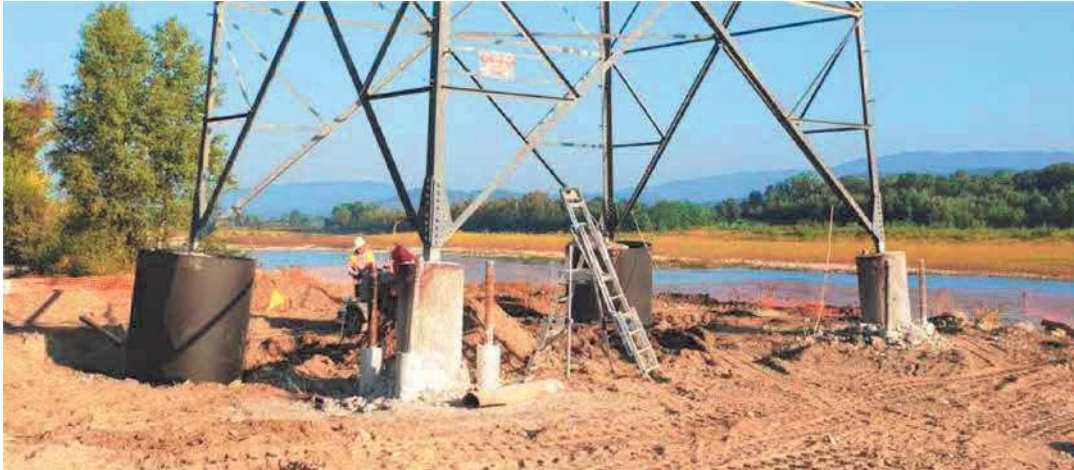
Photo permettant d'illustrer la partie aérienne des fondations spéciales
