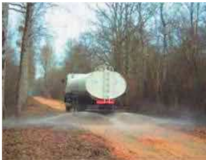
Illustration d'arrosage de piste de chantier permettant de limiter l'envol de poussières
