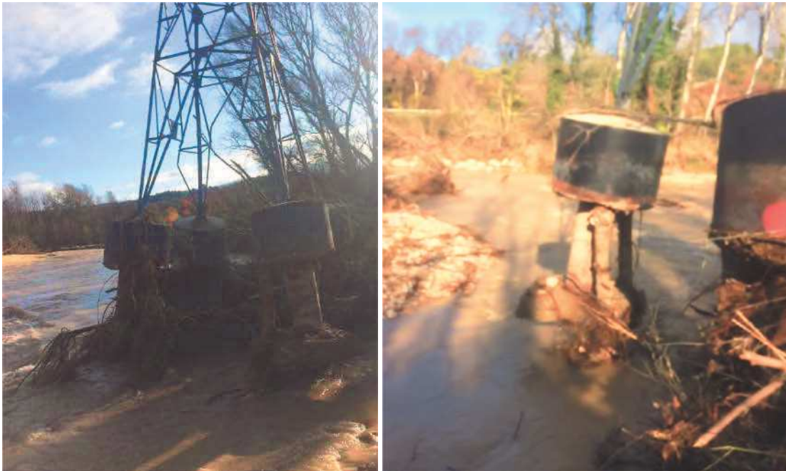
Figure 2: Illustration des impacts d'une crue de la Durance sur un pylône 63kV (Apt-Beaumettes) lors des crues de Novembre 2019
