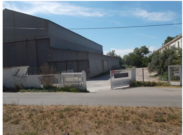
Vue de l'entrée du site
