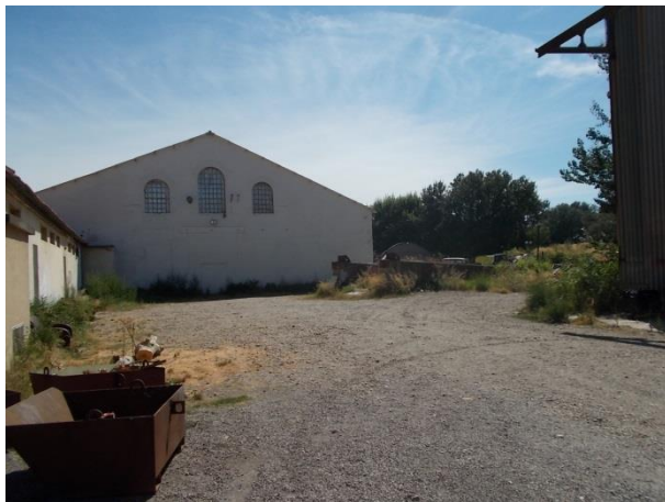
Vue de la zone de circulation à l'entrée du site à l'Est
