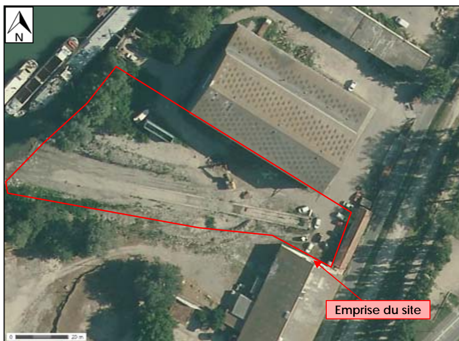
Figure 2 : Photographie aérienne du site en 2011 (Géoportail 2015)
