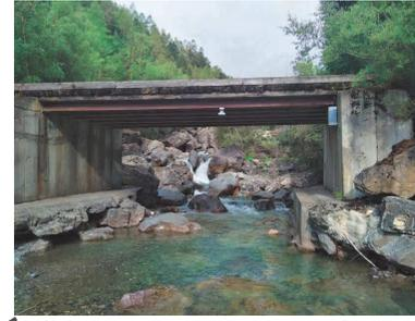
Pont de Serre (passage à côté du tablier du pont avec des supports indépendants).
