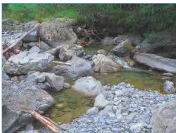
Seuil rustique de la prise d'eau
