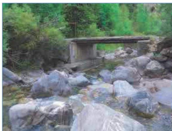
Pont de la Serre
