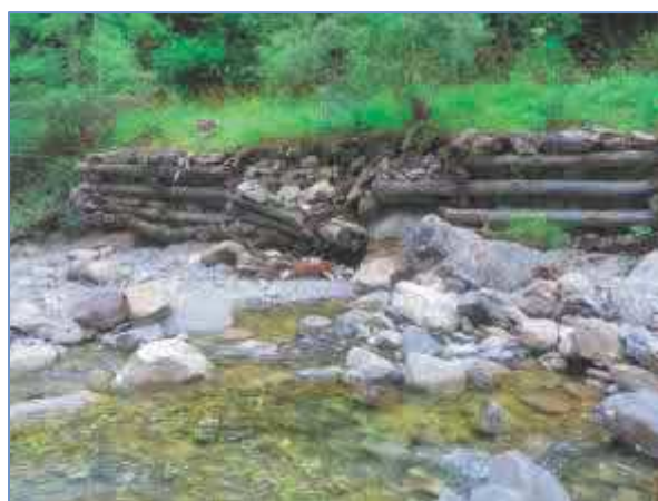
Confortement de berge pour sécuriser le canal
