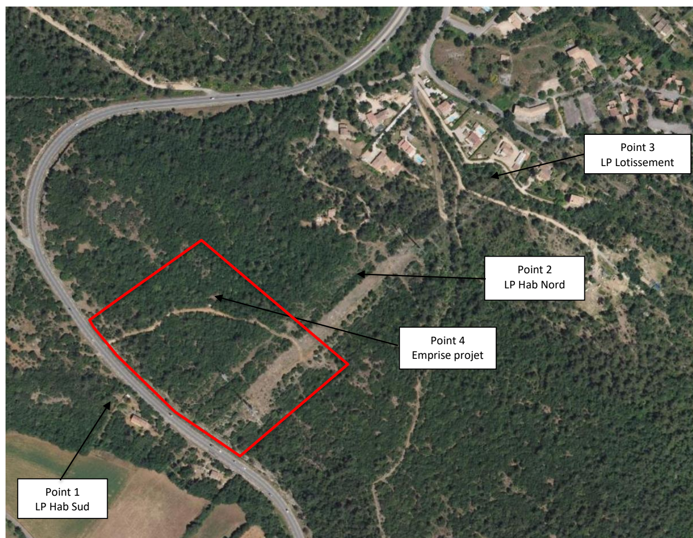
Illustration 4 : Localisation des points de mesures acoustiques
