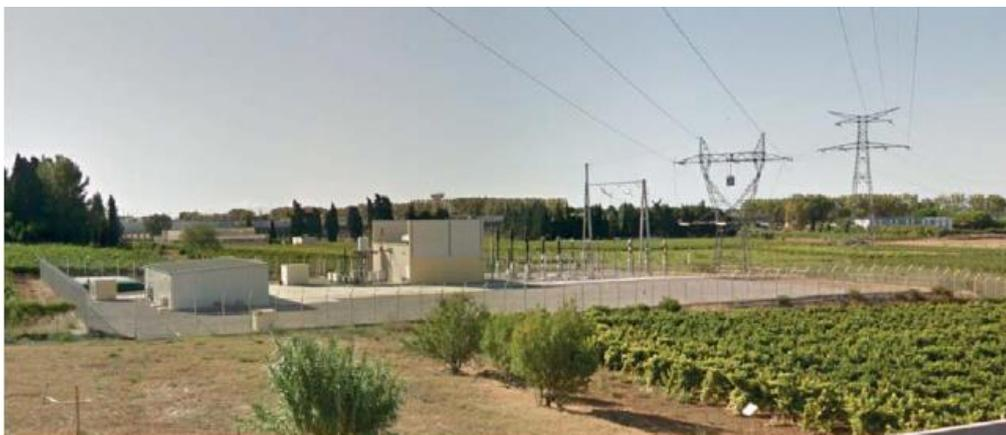
Illustration 13 : Exemple de poste de transformation 225 000 / 20 000 volts (Pont-Trinquat, Hérault)
