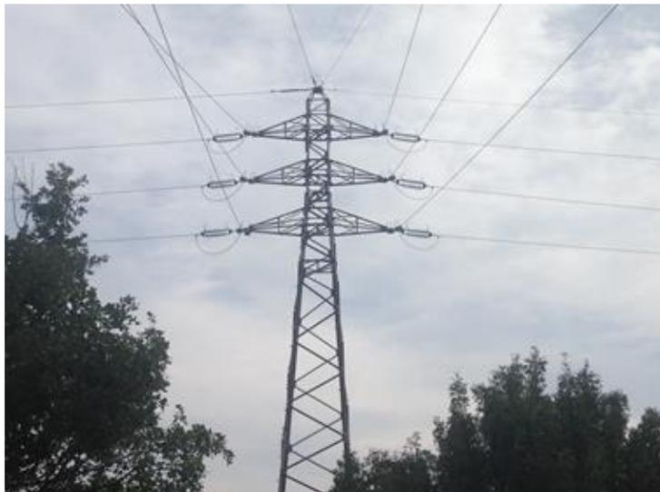
Illustration 14 : Exemple de pylône RTE de raccordement en coupure d'artère
