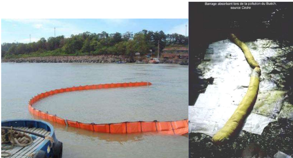
Figure : Installation d'un barrage flottant ( http://www.flexitankchina.fr ) / Barrage absorbant ( cedre.fr )
