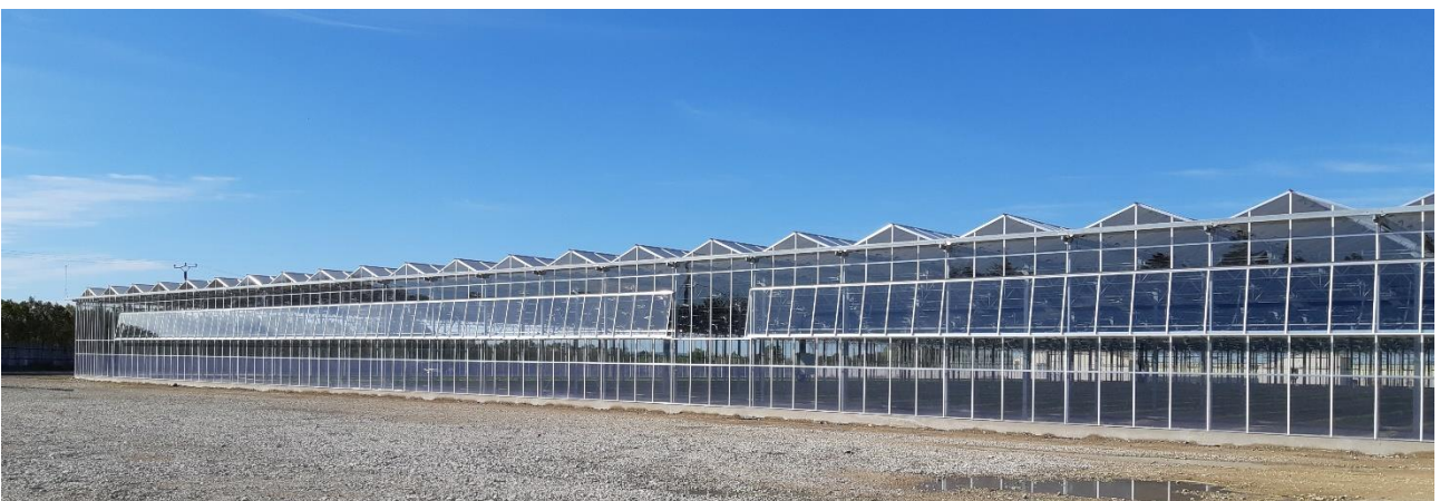
Figure 20 : Ouvrants en façade - Source : Reden Solar
