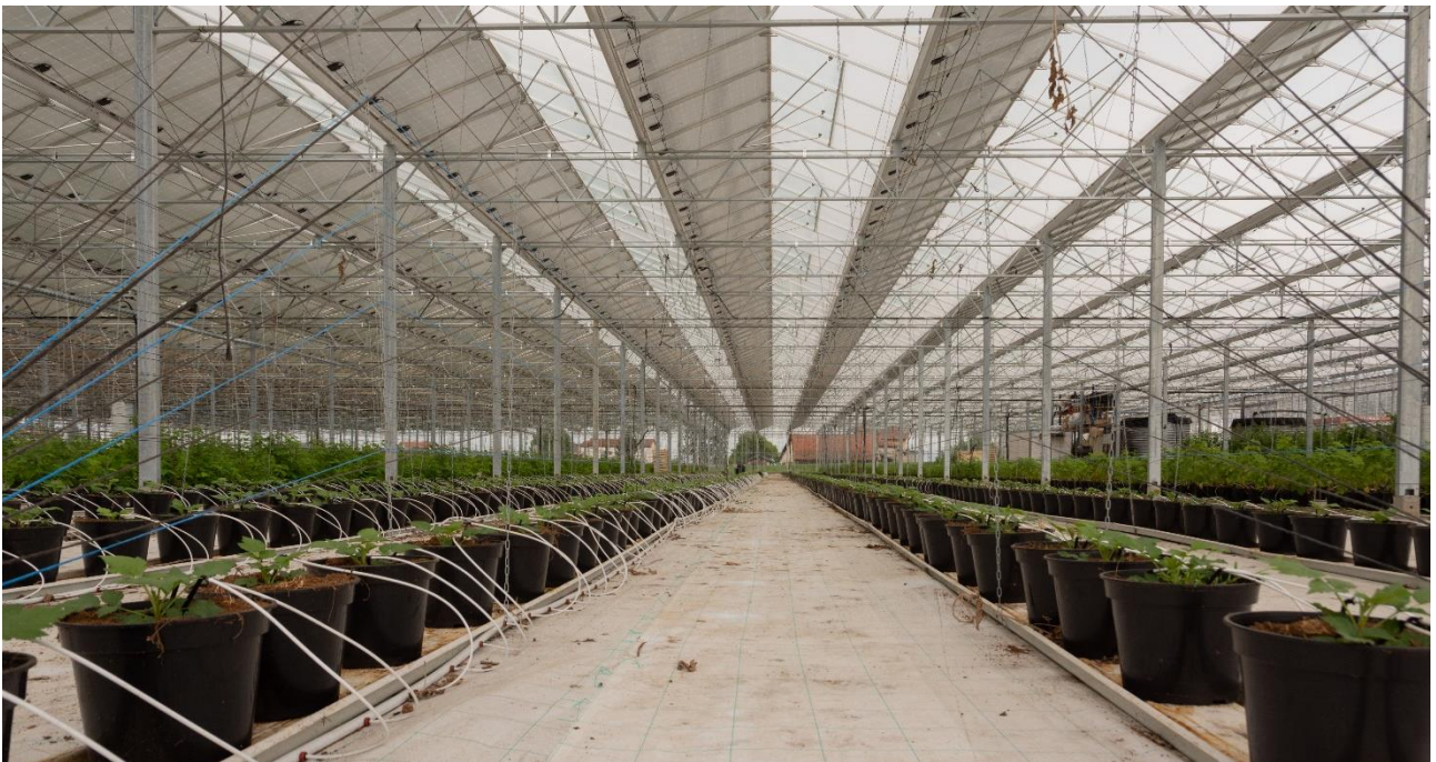
Figure 8 : Exemple de système d'irrigation par goutte-à-goutte, sous serre agricole photovoltaïque - Source Reden Solar
