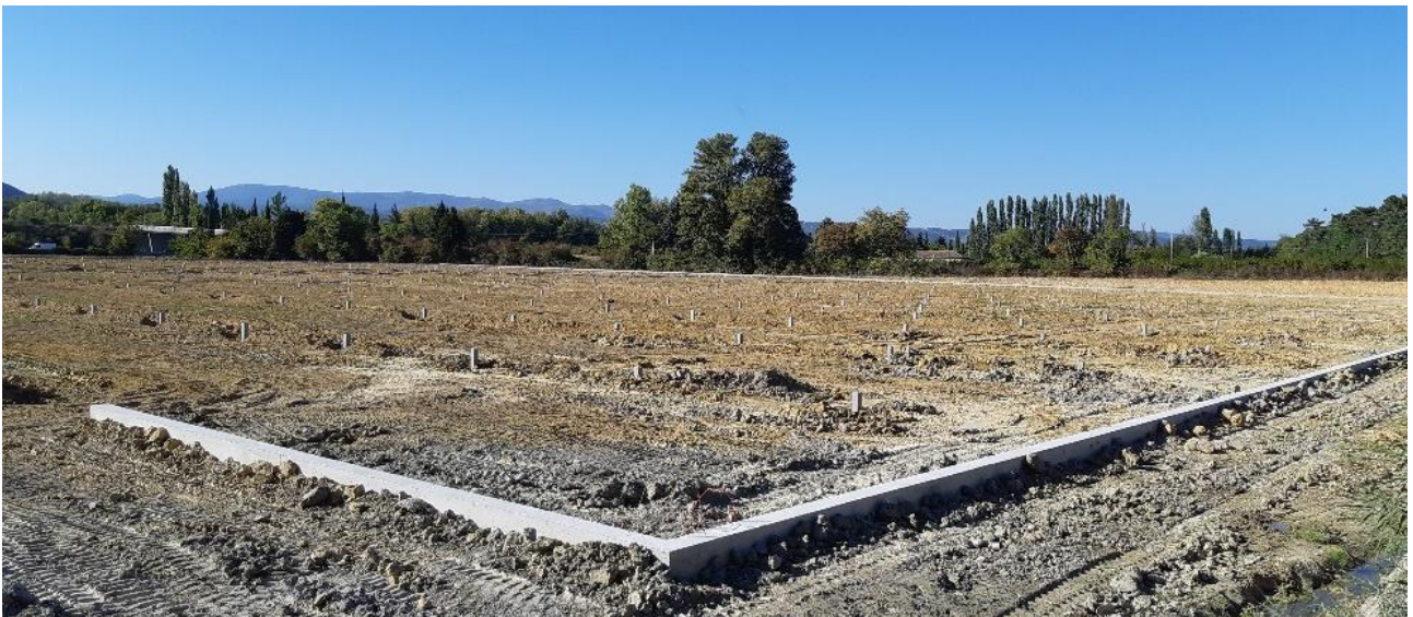
Figure 21 : Fondations béton extérieures (longrine) - Source : Reden Solar
