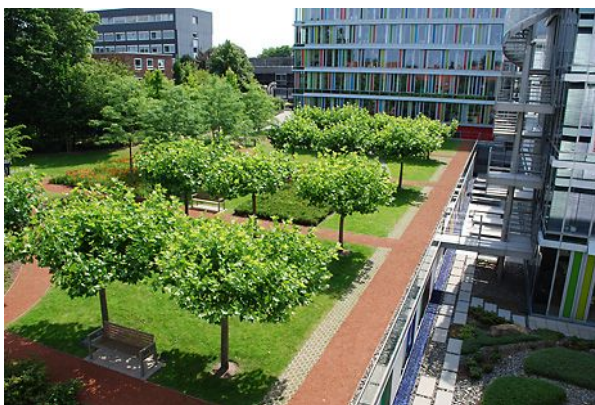
Toiture végétalisée – jardin
