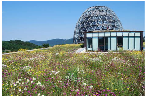
Toiture végétalisée – prairie naturelle
