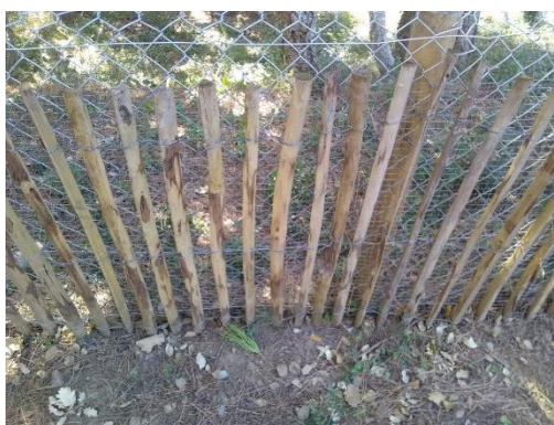
Exemple de clôture hermétique au passage des tortues (dans ce cas, le grillage au maillage fin n'a pas été incliné)
