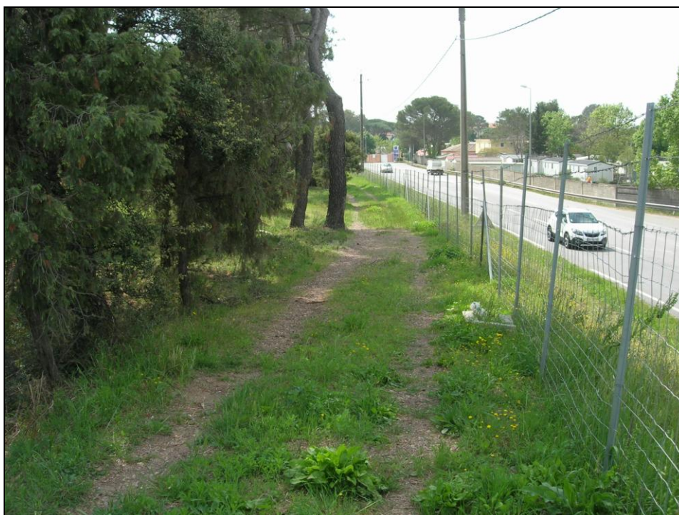
Photographie n° 5 : Les terrains du projet en partie basse le long de la RD4
