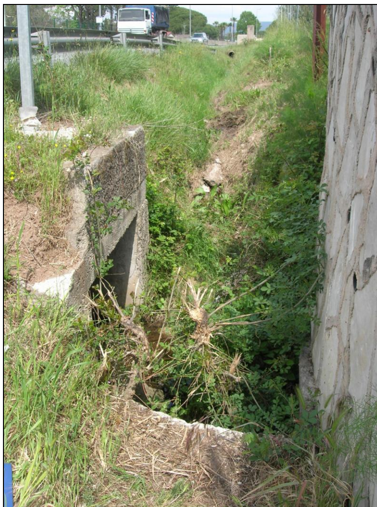
Photographie n° 6 : Le fossé pluvial de la RD4 se poursuivant en cadre béton sous la voie
