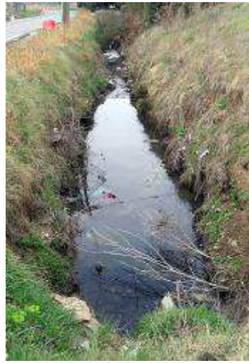
Fossés le long de la RD 12
