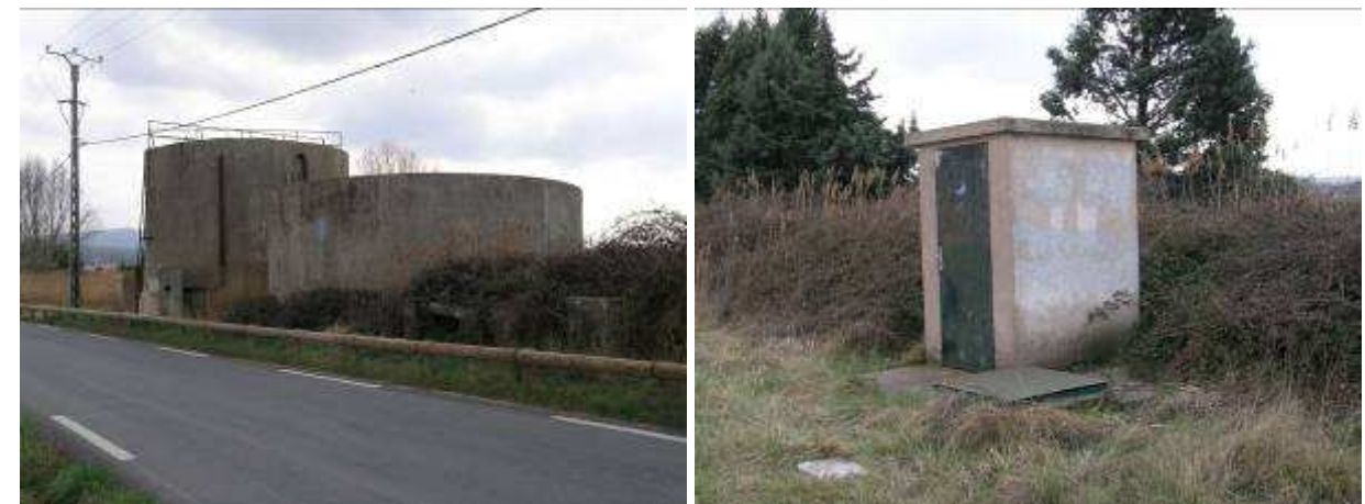
Ancienne station d'épuration - Transformateur
