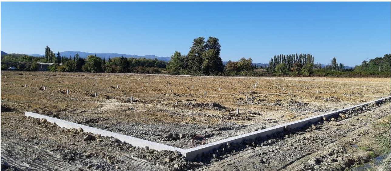
Figure 22 : Fondations béton extérieures (longrine) - Source : Reden Solar
