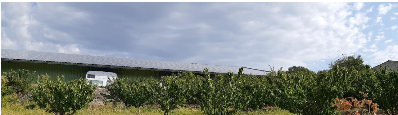
Figures 3 : Les bâtiments de l'exploitation
