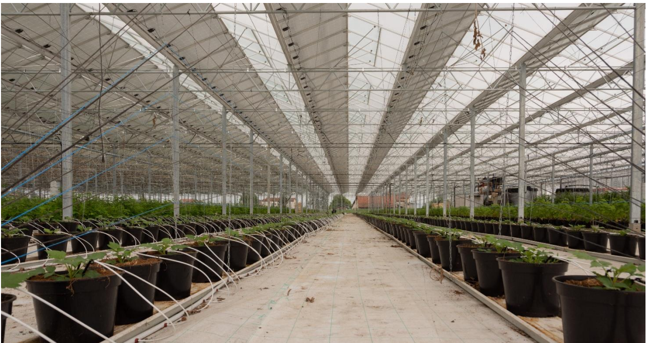
Figure 7 : Exemple de système d'irrigation par goutte-à-goutte, sous serre agricole photovoltaïque - Source Reden Solar
