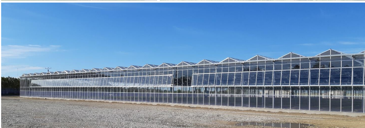
Figure 21 : Ouvrants en façade - Source : Reden Solar
