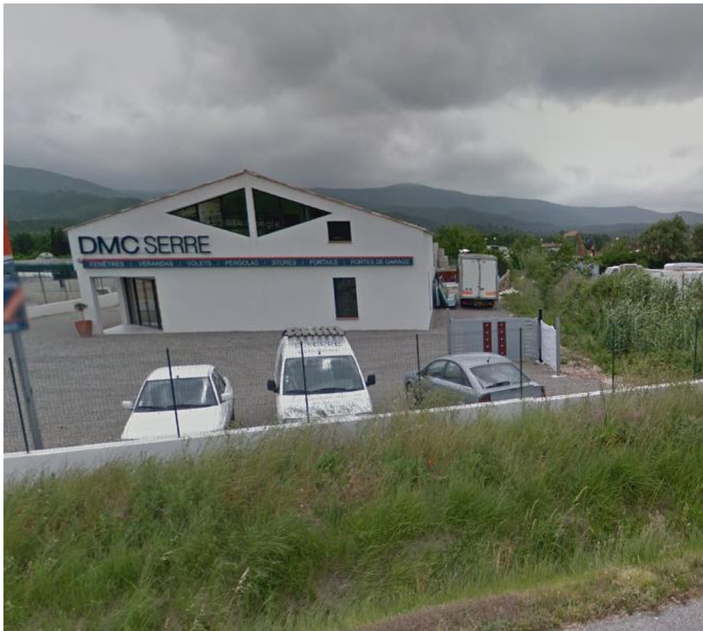
Figure 21 : Bâtiment type en R2 intégré dans la zone industrielle (Google earth)
