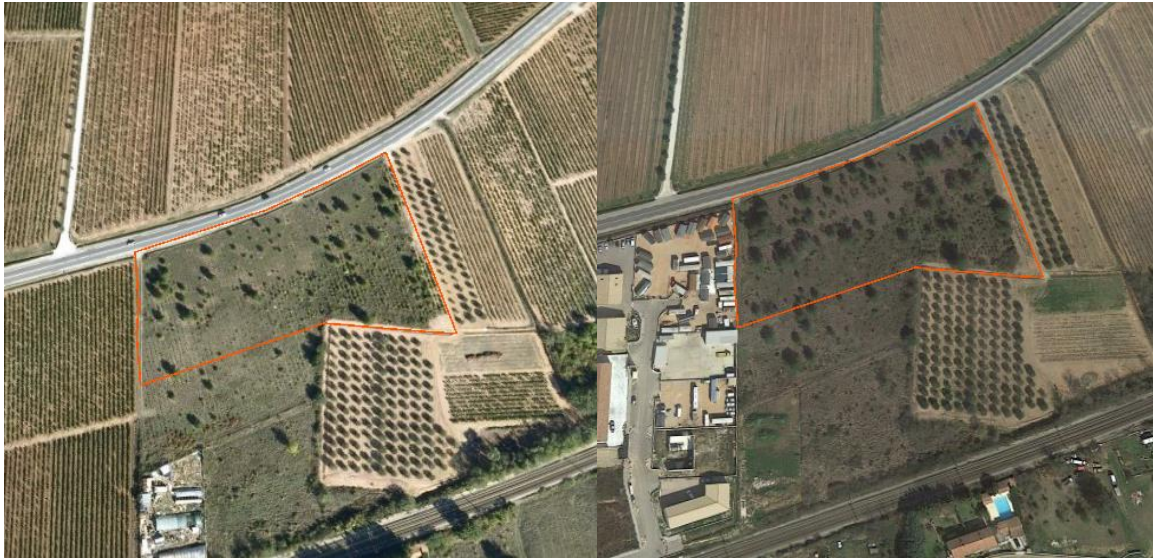
Figure 4 : Vue aériennes du secteur d'étude entre 2006 (gauche) et 2017 (droite) (Google earth)
