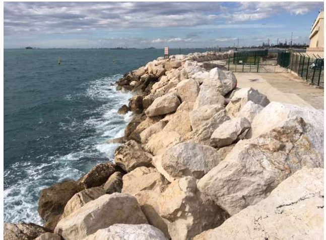
Vue de la zone 1 dans le sens Est-Ouest (talus)
