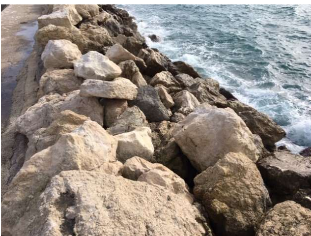
Vue de la zone 3 dans le sens Est-Ouest (talus)
