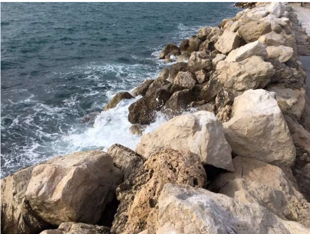
Vue de la zone 2 dans le sens Ouest-Est (talus)
