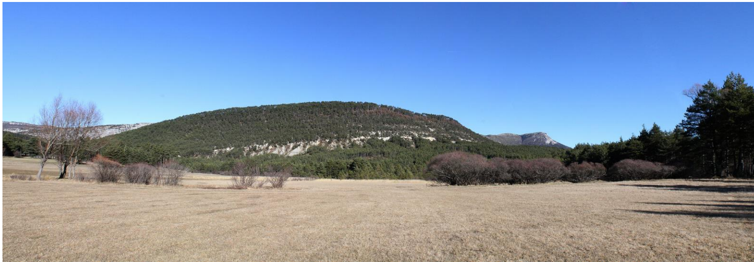
Photographie n°1 : Vue lointaine de la centrale photovoltaïque, prise depuis le point de vue n°1 représenté sur l'annexe 2 -
