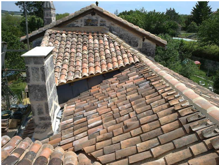
Principe de tuiles canal panachées avec casseaux
