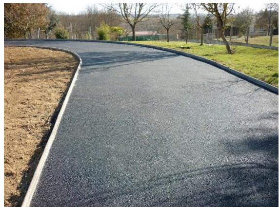
Enrobé et bordure béton clair
