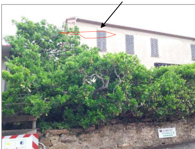
Photo 3 – Bâtisse à rénover intérieurement (bâtiment C)
