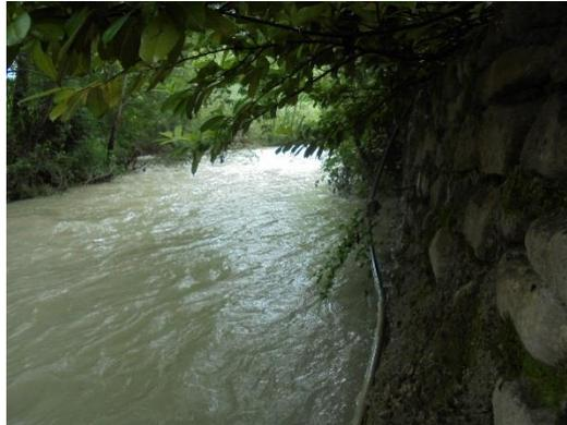
*Figure 6 : Mur en pierre maçonné protégeant les habitations en rive gauche.*
