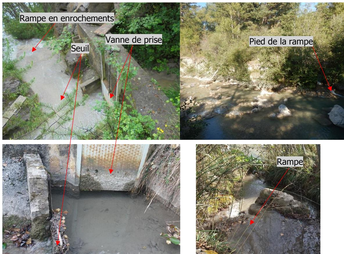
Figure 16 : Vue de la surverse existante (en haut à gauche) et du point de déversement dans le cours d'eau (droite).
