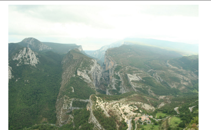
Aménagement du site Point Sublime - Couloir Samson
