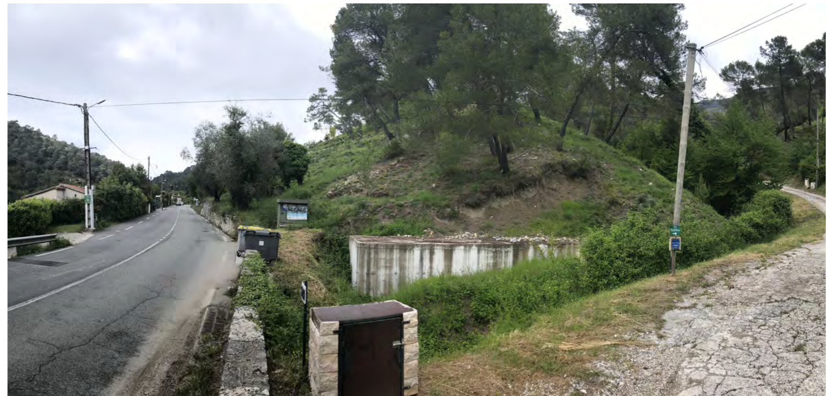
VUE 3 - PHOTOGRAPHIE ENVIRONNEMENT PROCHE
