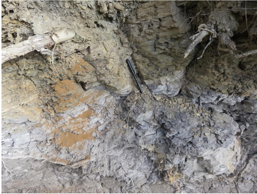
Figure 7 : Le substratum marneux et marno-calcaire en feuillets.
