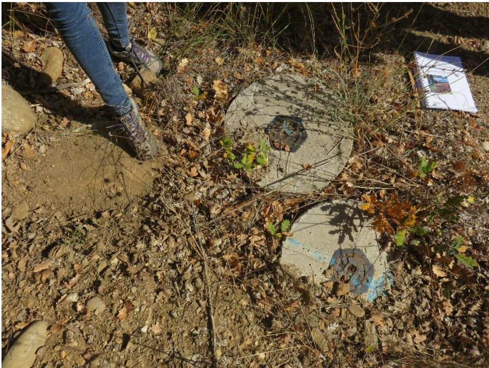
Figure 4 : Le raccordement des sources à la conduite générale.
