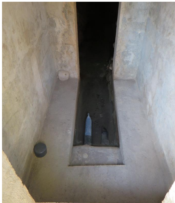
Figure 16 : Photographies (a) de l'entrée du captage de la source n°7 et (b) de l'intérieur du captage et l'entrée dans la cavité drainante.
