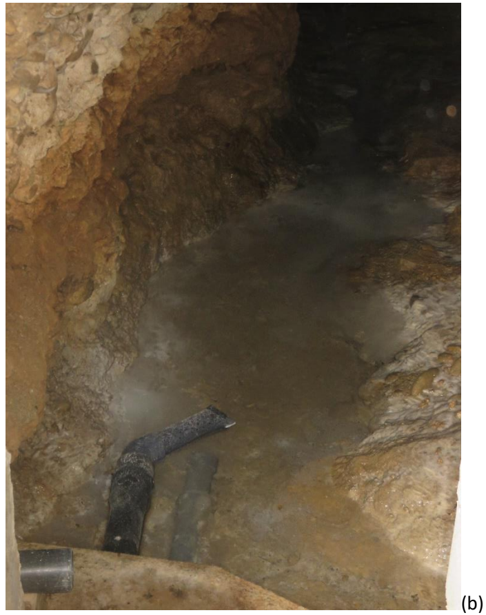
Figure 13 : Photographies (a) : de l'entrée du captage de la source n°5 et (b) de l'intérieur du captage et l'entrée dans la cavité drainante
