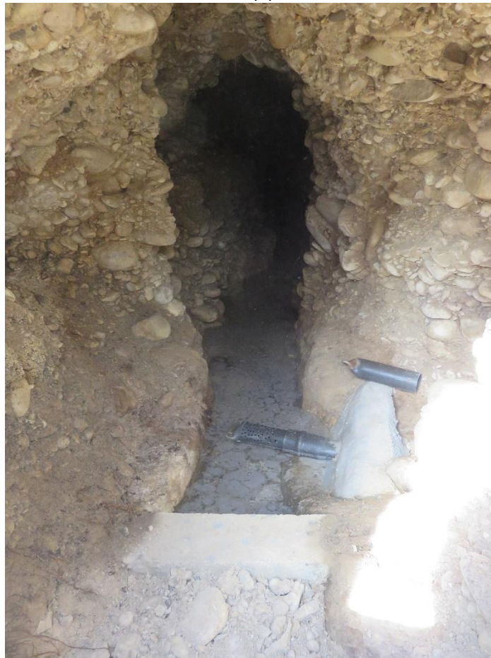
Figure 14 : Photographies (a) de l'entrée du captage de la source n°6 et (b) de l'intérieur du captage et l'entrée dans la cavité drainante
