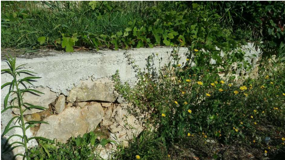
Figure 21 Photographie d'un muret d'une construction abandonnée (source : ECOTONIA)
