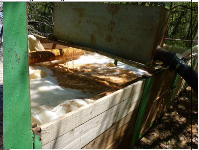
2/03/16 :Durant les tests d'air lift sur S3, un bac de décantation permet d'abattre la turbidité
