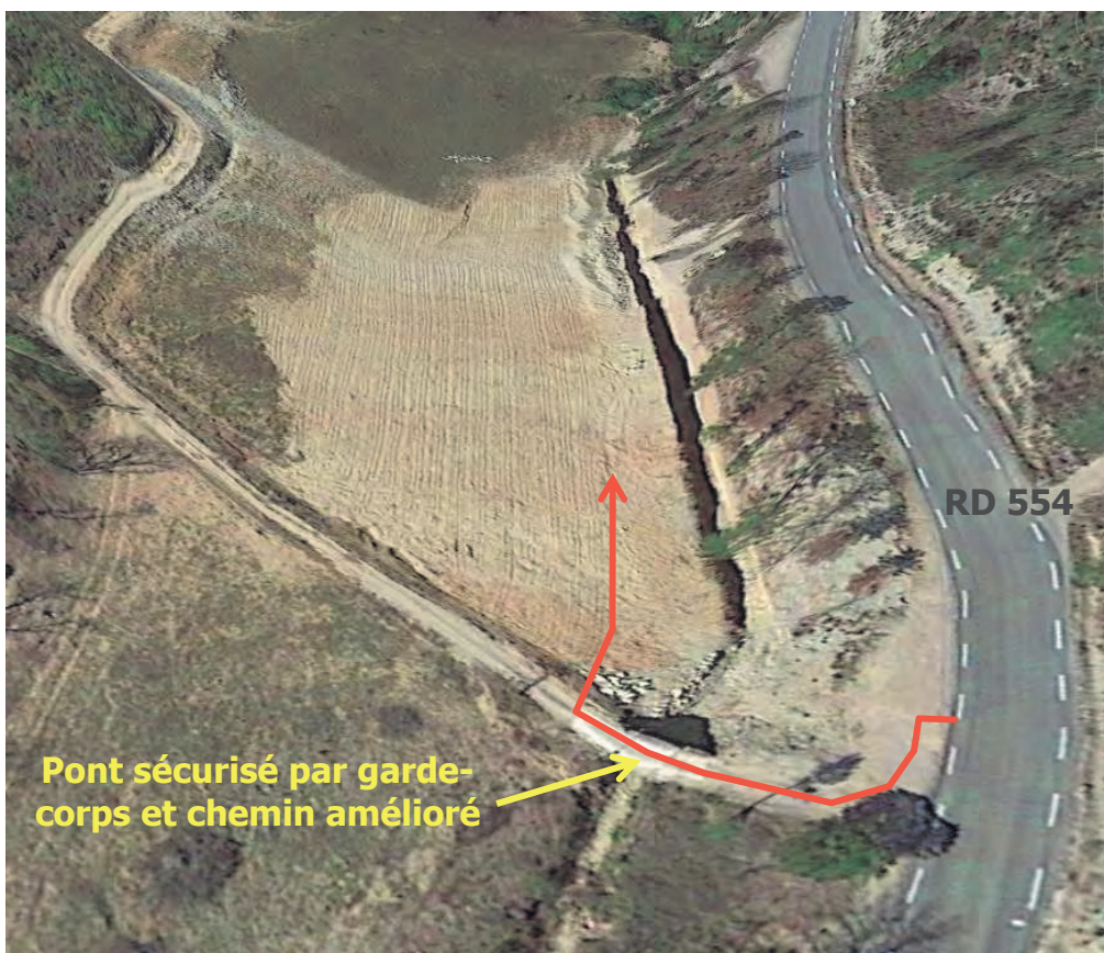
Figure 5 : Accès au site de travaux (Source : Géoportail)
