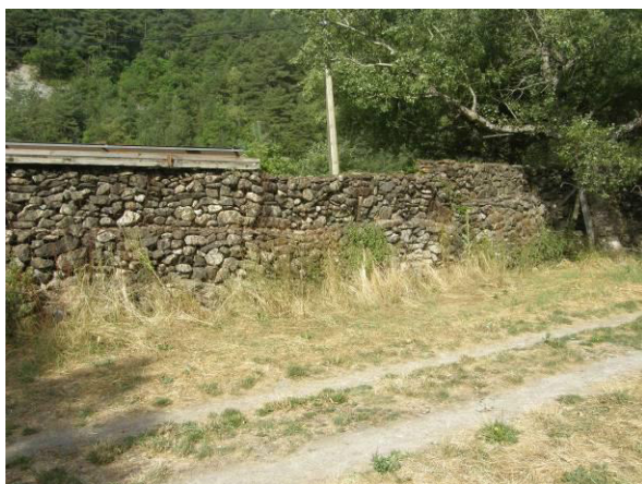
Digue en gabions
