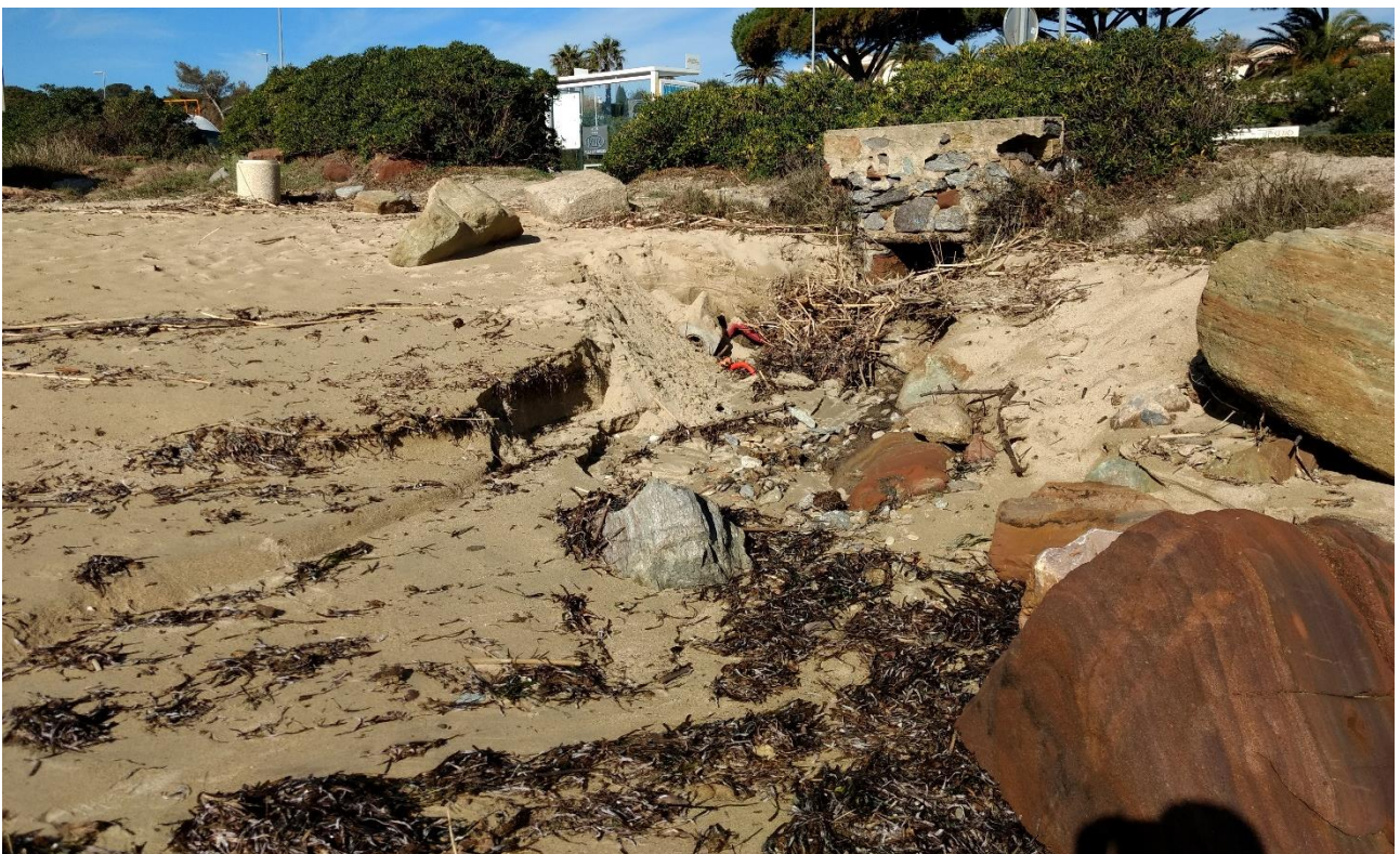
Figure 4 – Photographie de l'exutoire pluvial à l'ouest de la partie terminale de l'ouvrage longitudinal (sur la plage de Guerrevieille) en mars 2018
