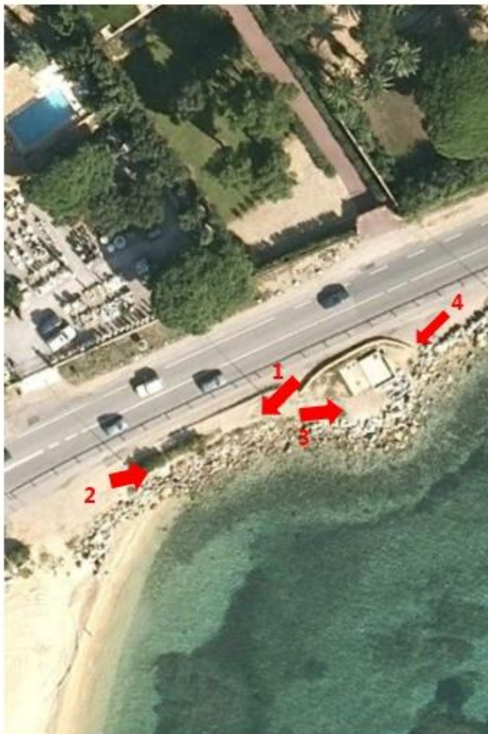
Talus en enrochements le long du poste de relevage au Nord de la plage
