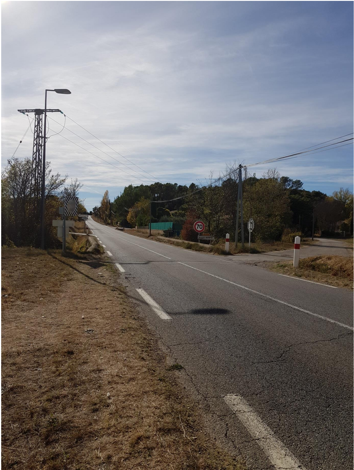
Figure 45 : Vue sur la RD560 vers le Sud et croisement avec la route de la chapelle (6)
