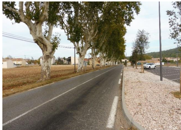
Figure 7 : Allée de platane interrompue le long de la RD 560
