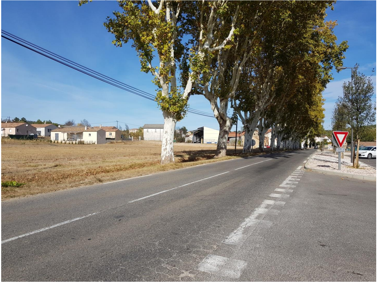
Figure 40 : Vue sur la RD560 en direction du Nord (1)
