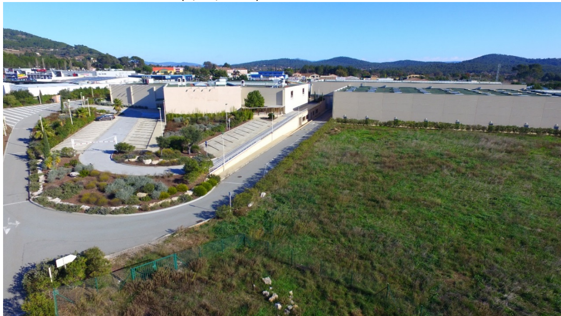
POINT DE VUE FACADE OUEST (5/01/2017)
