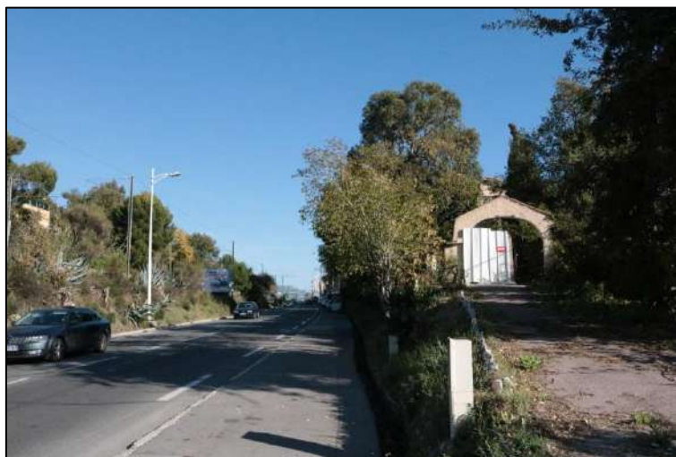
Vue n°1 depuis le site vers l'avenue de la gare (EVEN, novembre 2017)
