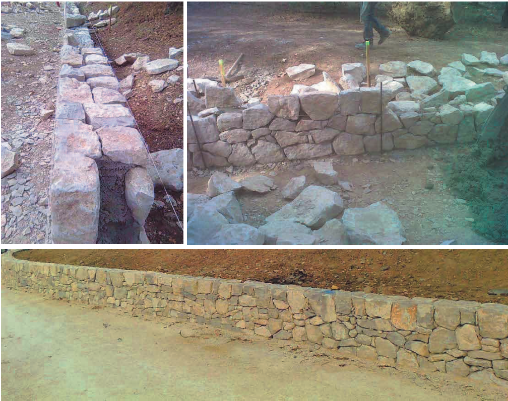
Muret de moellons calcaire appareillés : à noter les pierres d'angles supérieures taillées à angles droits et refermant le muret; âme du muret hourdée de béton, pas de joints extérieurs, calepinage soigné ajusté.
