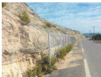
« Tunnel du Rove »
