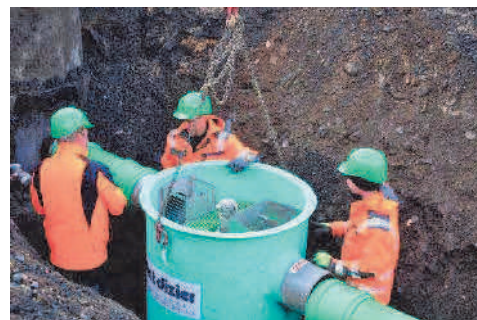
Mise en place du STOPPOL®
