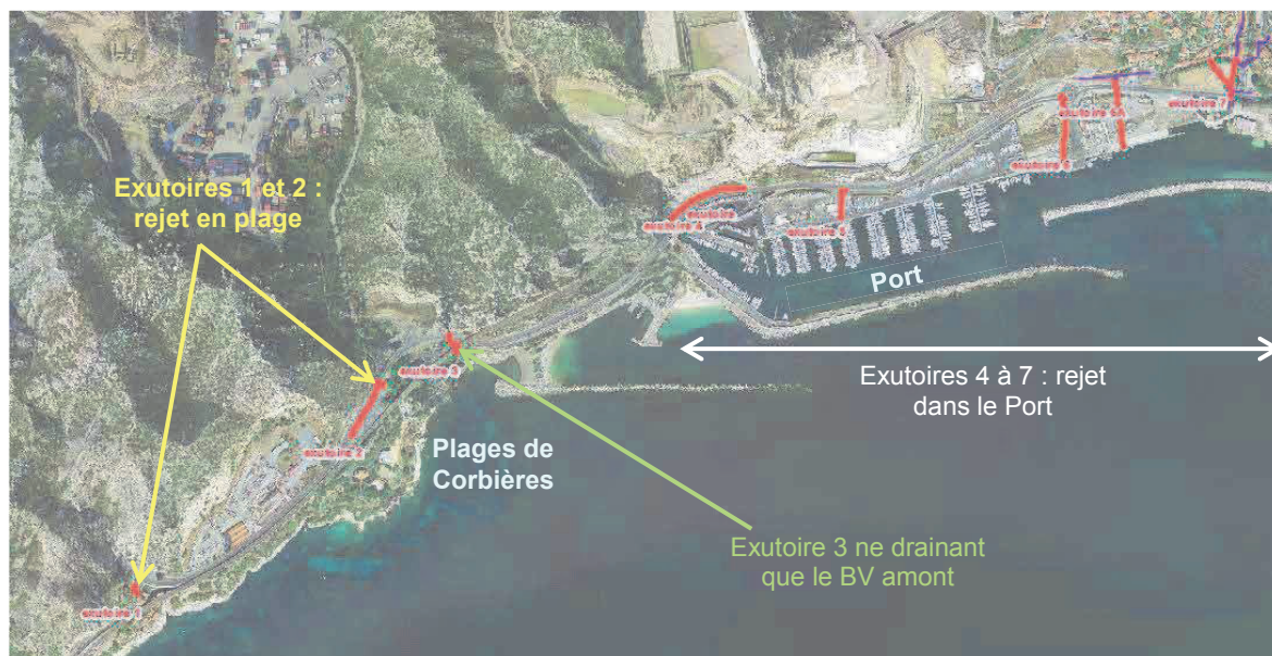
Fig. 13. Localisation des 2 exutoires au niveau des plages
