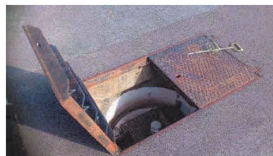
Implantation sous voirie avec accès total
