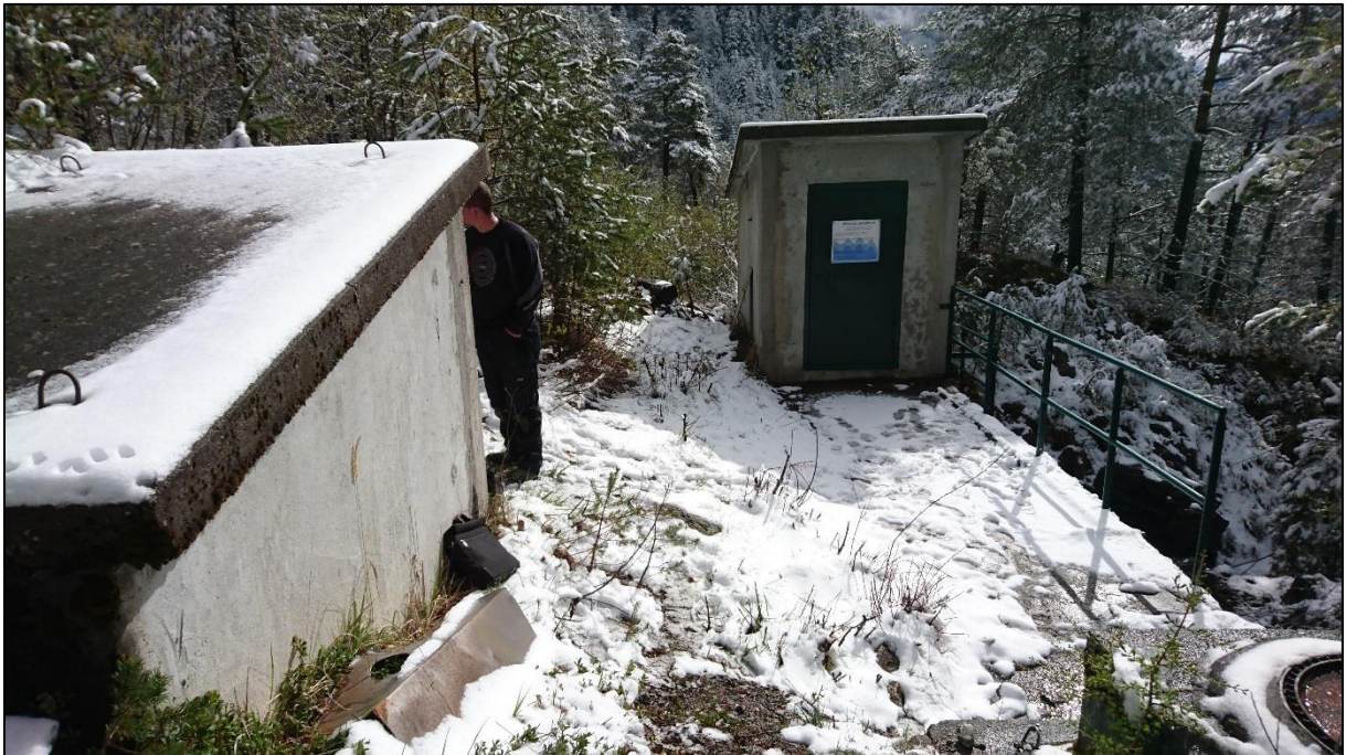
Chambre de captage (gauche) et microcentrale (droite)
