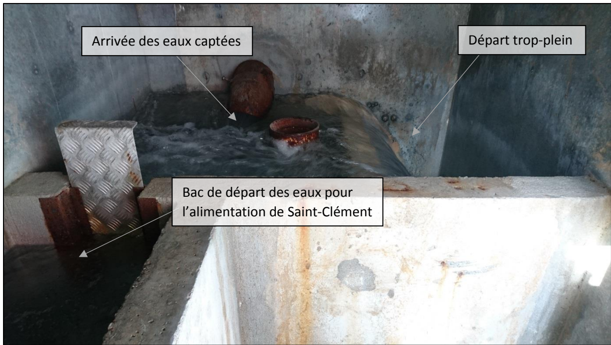
Intérieur de la chambre de captage
