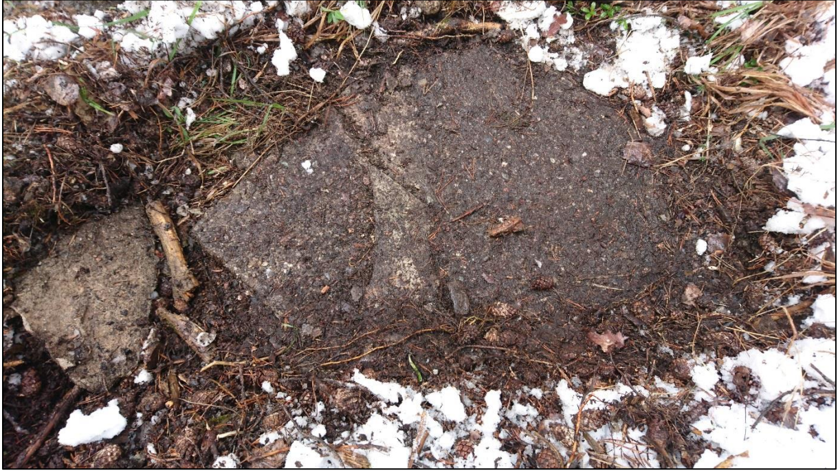
Dalle béton du captage de Bel Pinet
