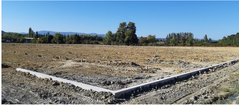
Figure 23 : Fondations béton extérieures (longrine) - Source : Reden Solar
