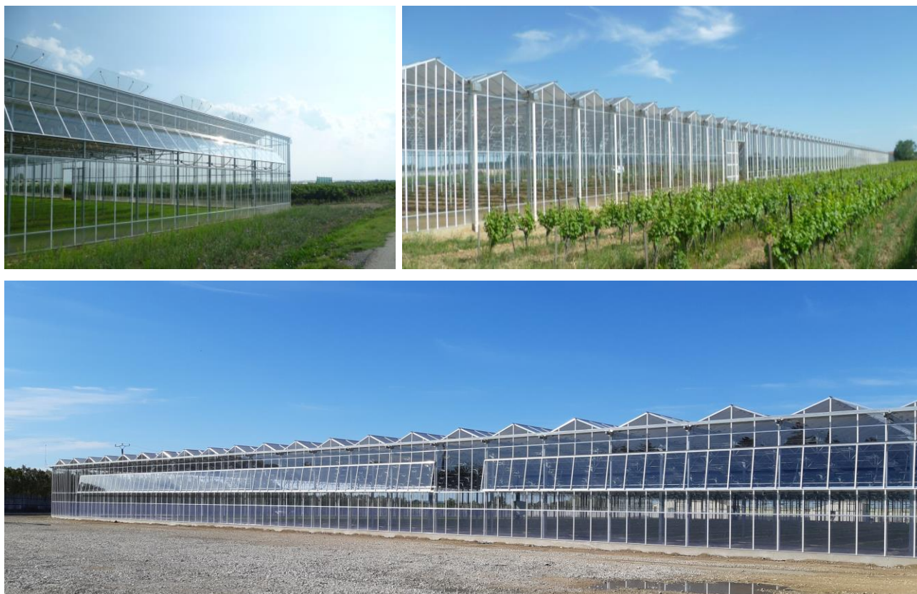
Figure 22 : Ouvrants en façade - Source : Reden Solar
