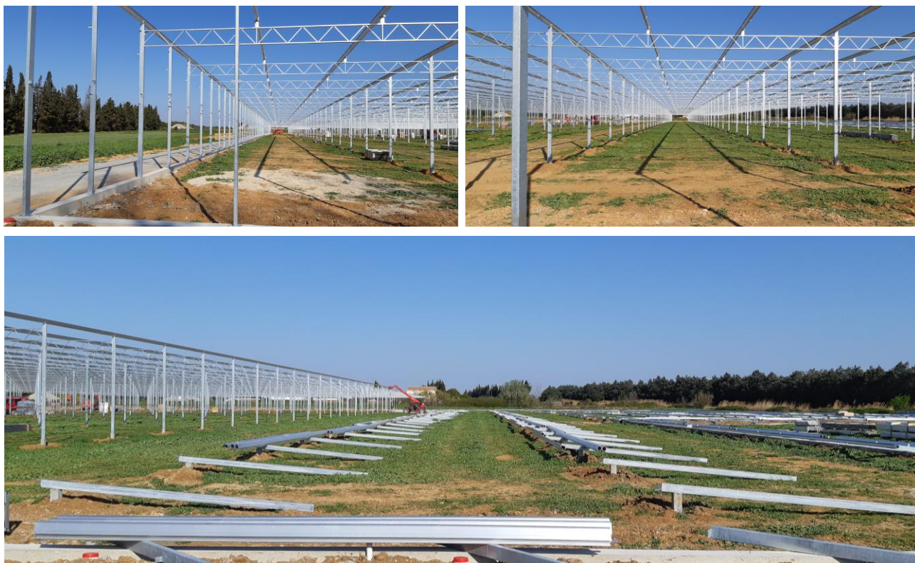
Figure 21 : Montage structure d'une serre photovoltaïque - Source : Reden Solar
