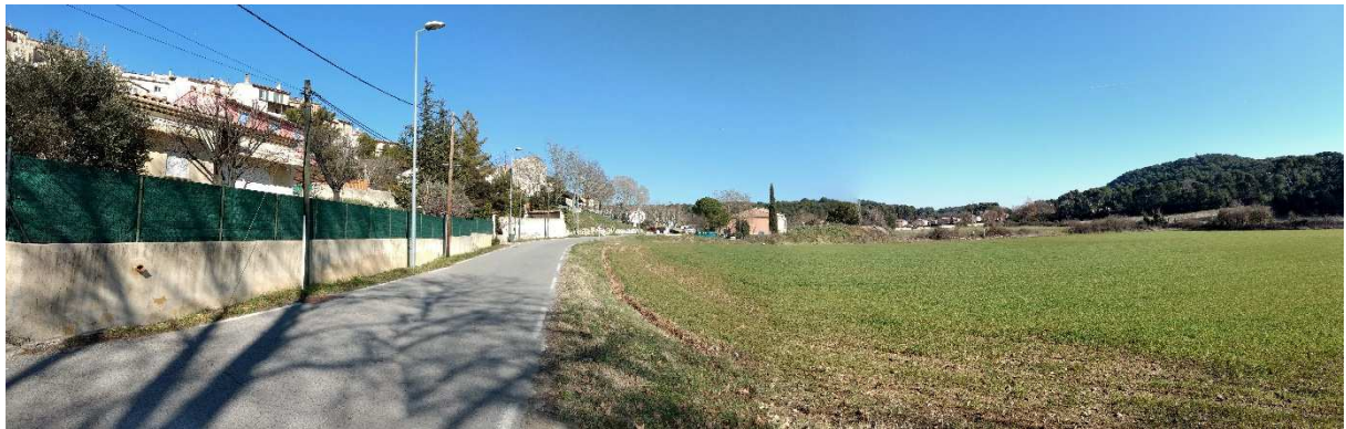
Vue 1 – Début de la déviation de la RD 60d (18/01/2019)
