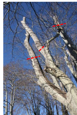
Platane N°7 : Réduction de tous les axes déclinants si l'arbre est conservé
