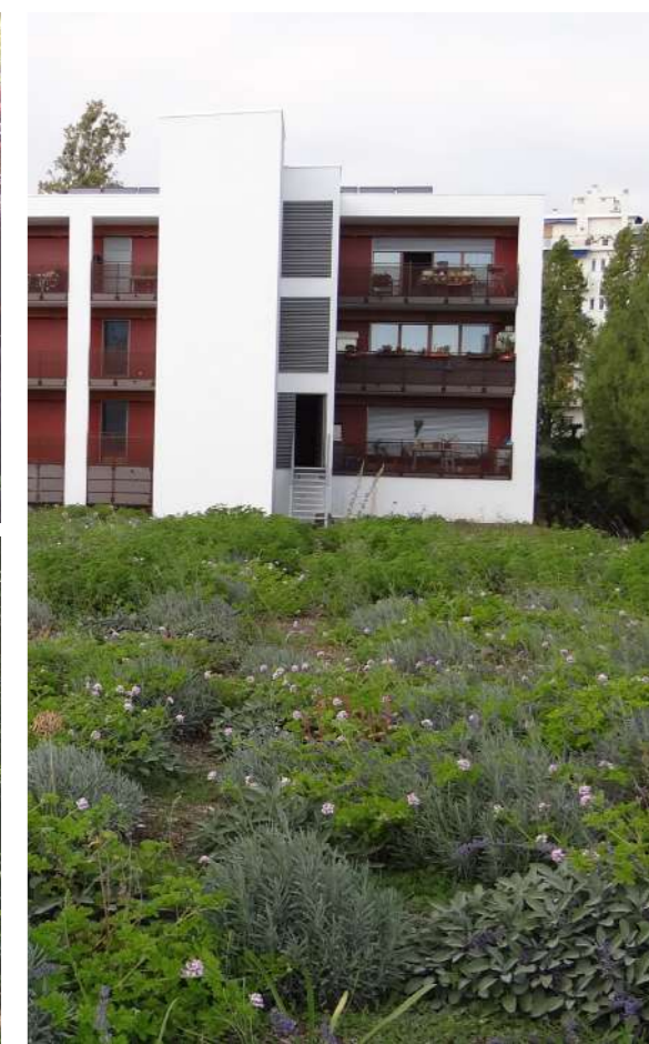
Toiture plantée au lycée de Eucalyptus
