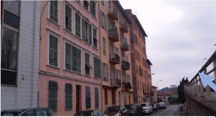
Immeubles de logements Route de Turin
