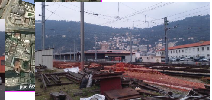
Terrains SNCF – Voie ferrée et plateforme logistique
