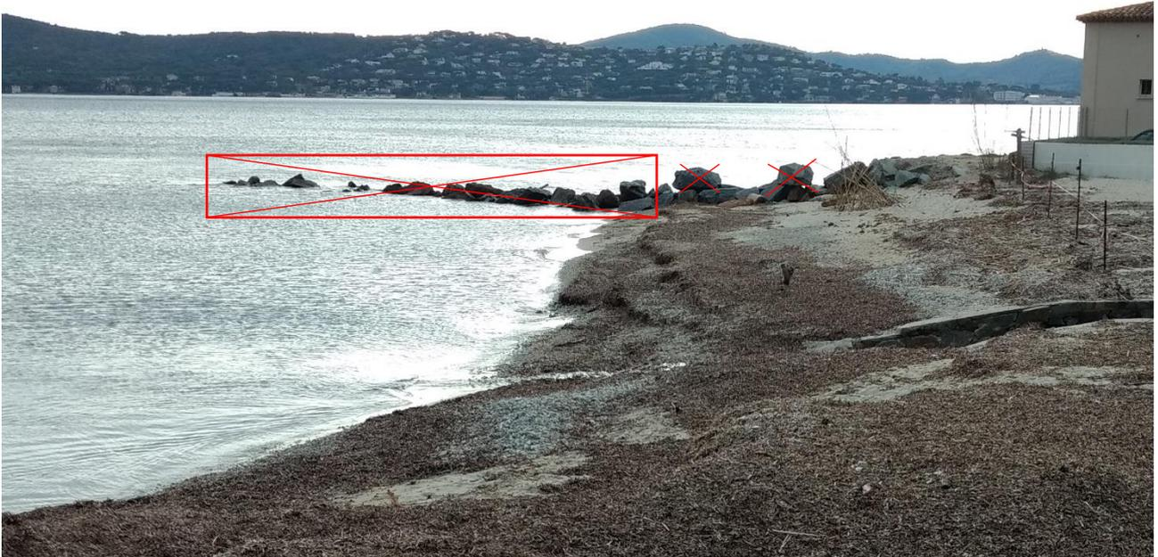
*Figure 8 – Schéma de principe des blocs retirés à la pointe de Guerrevieille (photographie de janvier 2019)*
