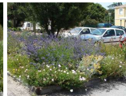
Noue végétalisée arbustive
