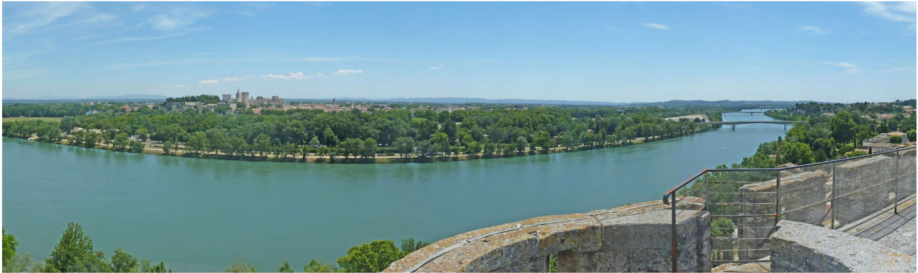
04 - VUE DEPUIS LA TOUR PHILIPPE LE BEL existante
