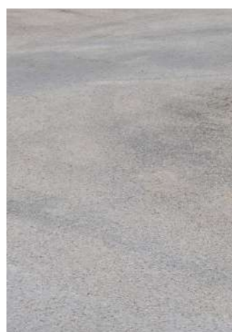
Bicouche : voies internes et stationnement
