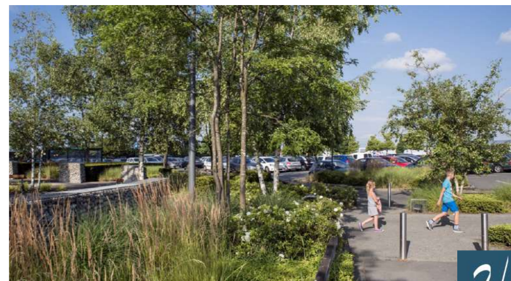
Noue végétalisée arbustive infiltrante
