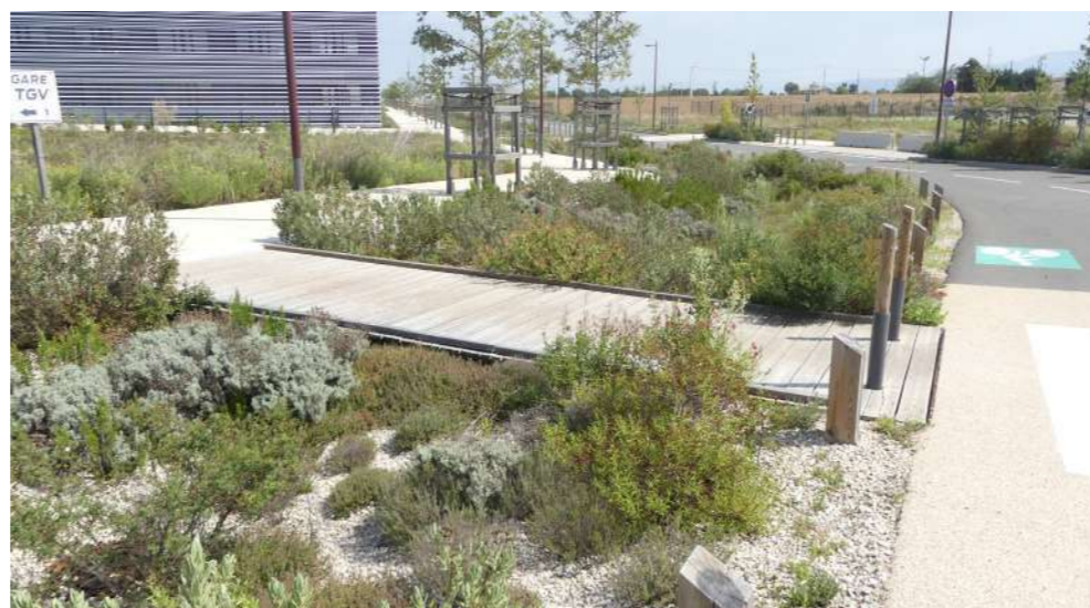
Noue végétalisée et passerelle bois
