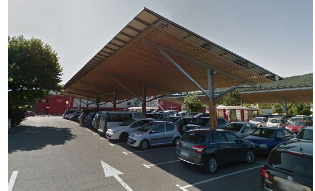
Ombrières avec sous face lamelles bois Supermarché de Gap (05)
