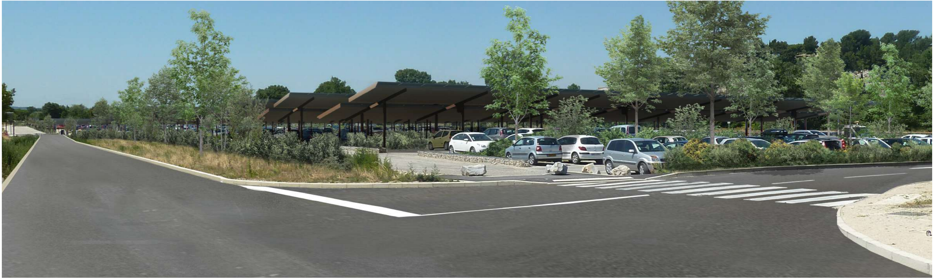
01 - VUE DEPUIS LE NORD-EST DU PARKING
