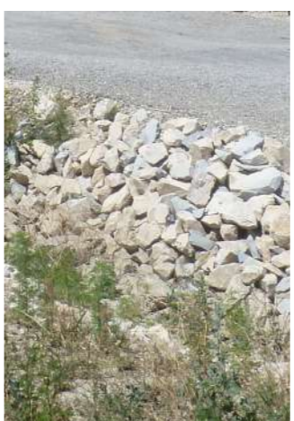
Enrochements : évacuation noues et fossés
