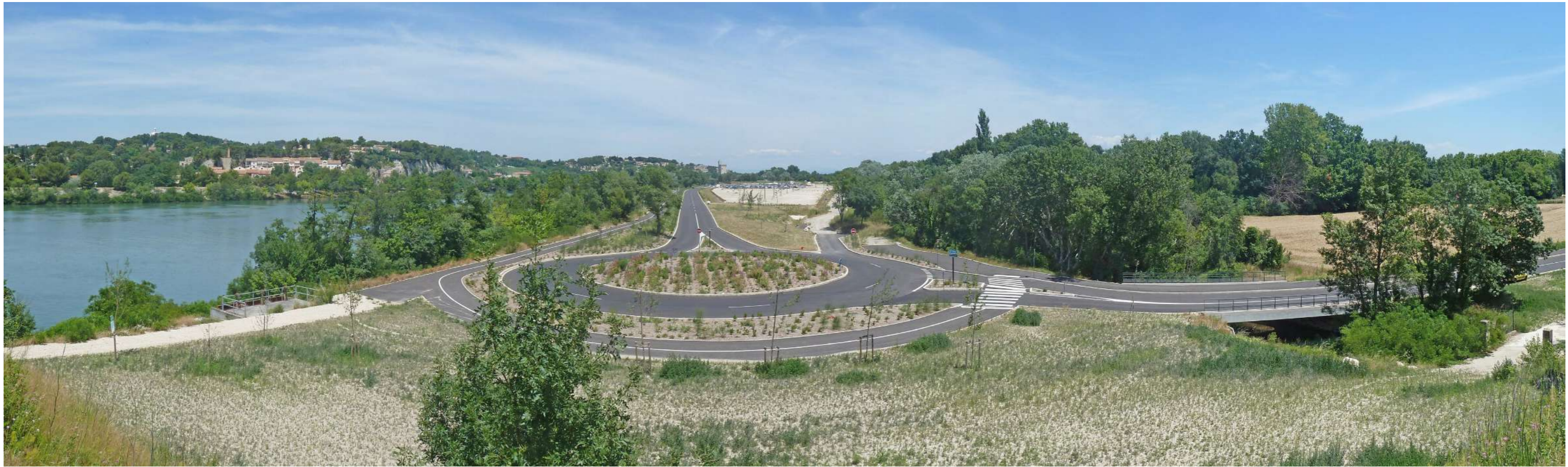
03 - VUE DEPUIS LE PONT DE L'EUROPE existante
