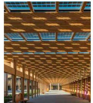
Panneaux photovoltaïque structure bois
