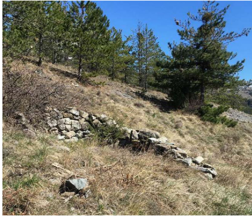
MURET EN PIERRE
