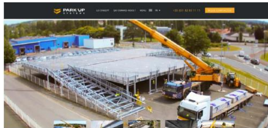
Figure 18 : Montage d'un parking silo préconstruit (source : PARK UP)
