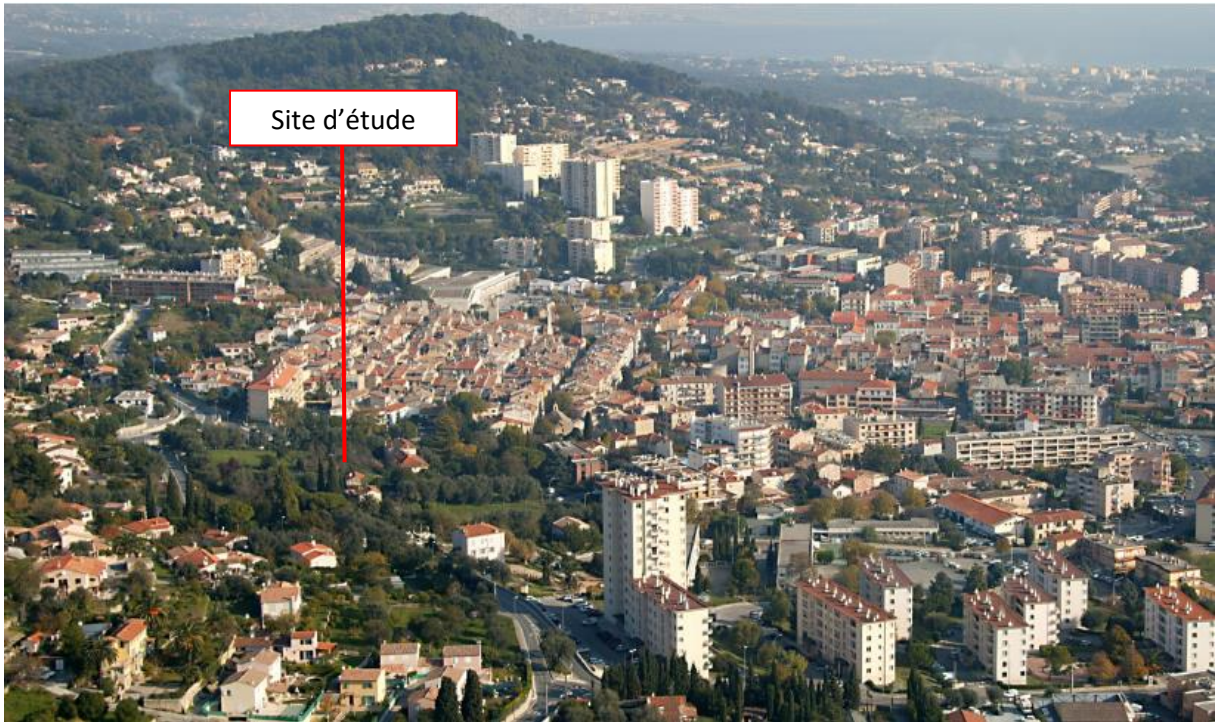
Vue aérienne générale
