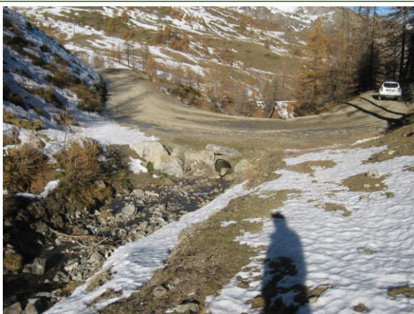
Passage busé sous la piste
