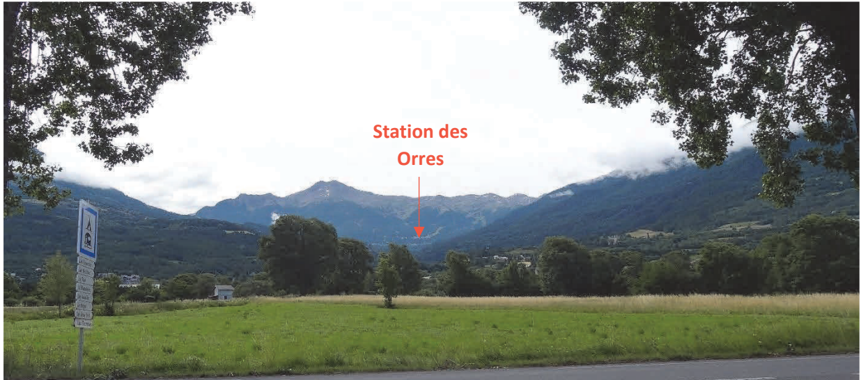
Vue 1 lointaine de la station des Orres depuis la zone d'activité de Barratier (le long de la RN94) incluse dans le site inscrit du barrage de Serre-Ponçon. Source : D. Ruhland (Karum).
