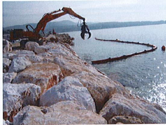
Figure : Pose d'écrans verticaux anti-turbidité, balisage des biocénoses sensibles.
